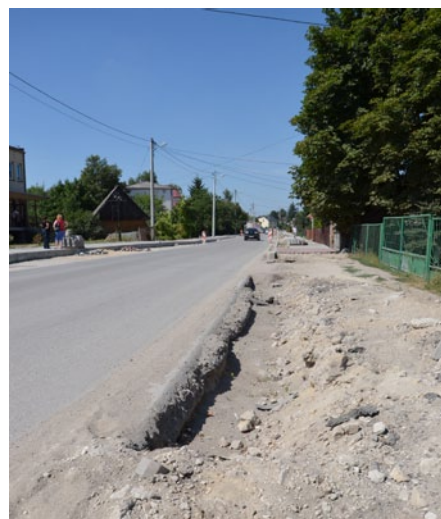
Robotnicy wykopali rowy pod krawężniki i odjechali pracować gdzie indziej.
