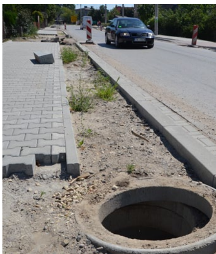
Odkryta studzienka przy ulicy Częstochowskiej
