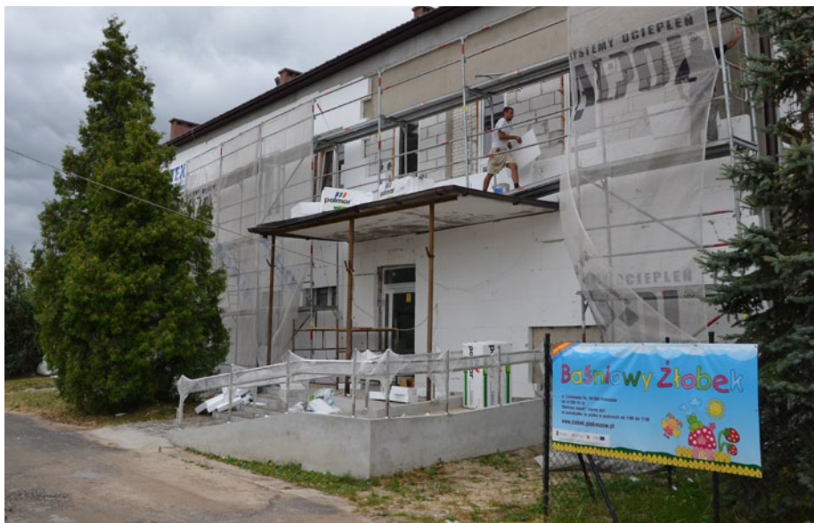
W tym roku popegeerowski biurowiec przeszedł gruntowny remont. Od września będzie w nim funkcjonował żłobek.
