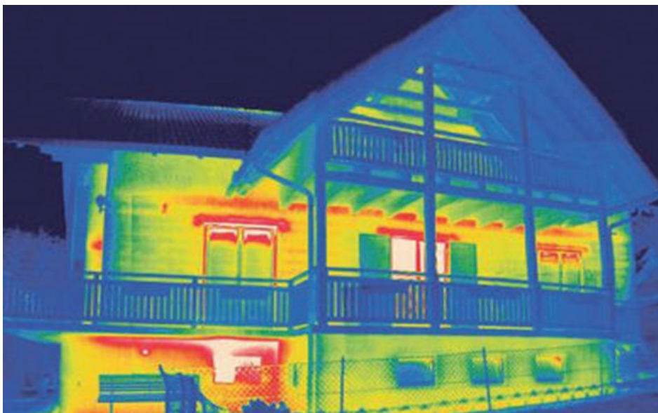
Obraz nieocieplonego budynku widziany okiem kamery termowizyjnej jako narzędzie wspomagające audyt energetyczny.
