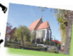
Kościół Św. Bartłomieja Apostoła w Chotlu Czerwonym
