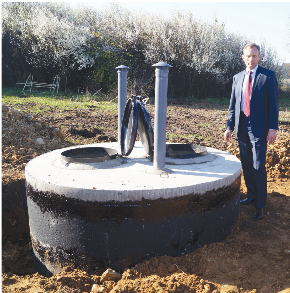
Efekty prac po wydrążeniu i obudowie studni obserwował Wójt Zbigniew Piątek.
