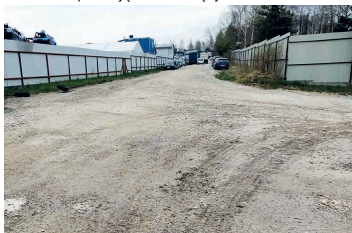
Ulica Recyklingowa w Piekoszowie przejdzie kompleksowy remont. (fot. CKinfo)
