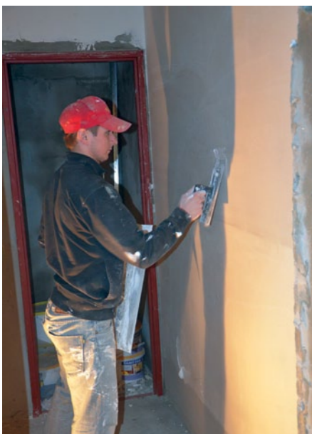
Na parterze Gminnego Ośrodka Kultury powstaje toaleta.
