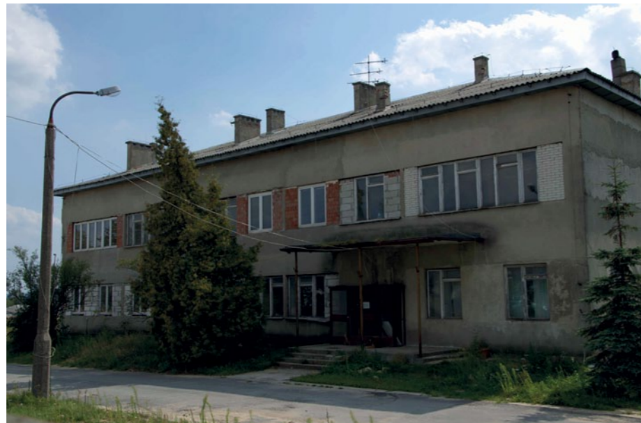
Tak jeszcze kilka miesięcy temu wyglądał popegeerowski biurowiec w Piekoszowie. Po zakończeniu remonty będzie w nim między innymi żłobek.
