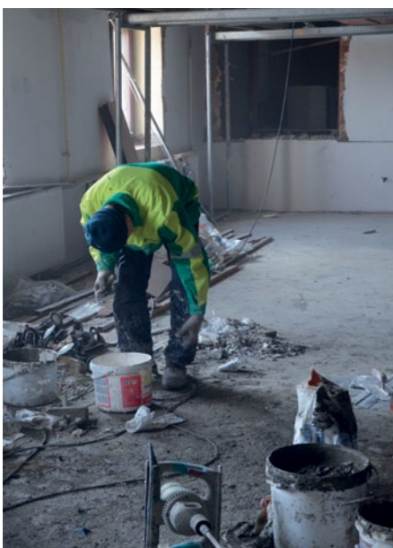
Remontowany jest cały parter Gminnego Ośrodka Kultury w Piekoszowie.
