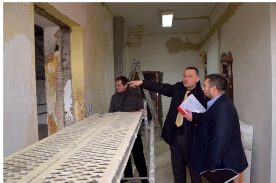
Paweł Nowak, dyrektor Gminnego Ośrodka Kultury w Piekoszowie pokazuje wójtwi Tadeuszowi Dąbrowie jak przebiegają prace remontowe.
