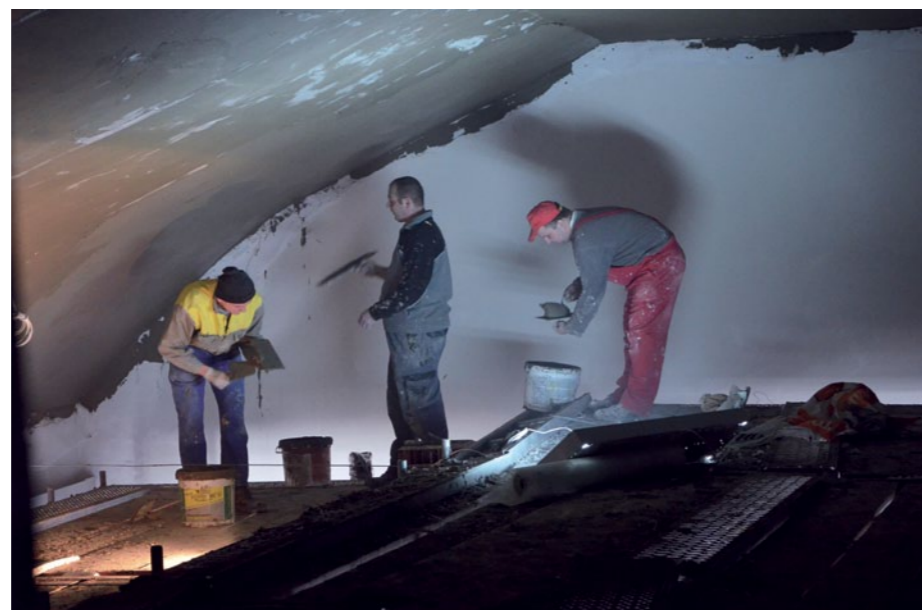
W największej sali Gminnego Ośrodka Kultury robotnicy docieplili sufit. Naprawiają także zniszczone tynk na ścianach.
