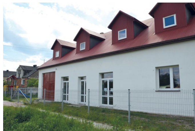
W budynku w którym funkcjonuje przedszkole w Szczukowicach trwa właśnie remont.
