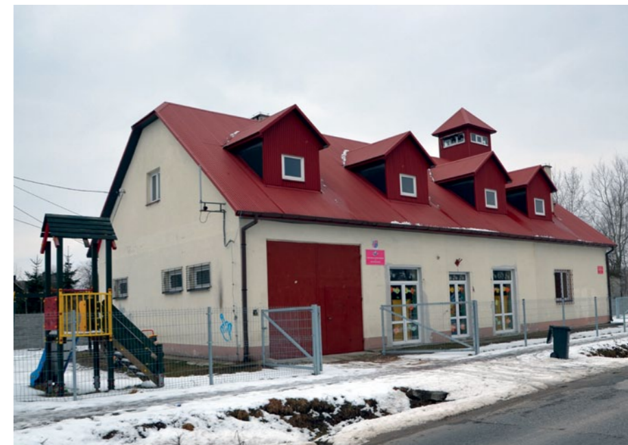
Lada dzień rozpocznie się remont budynku w którym mieści się świetlica, przedszkole i remiza OSP w Szczukowicach. Robotnicy docieplą także ściany i wymienią dach na budynku świetlicy i remizy w Rykoszynie.
