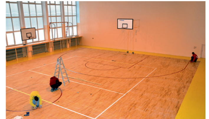
W szkole w Piekoszowie wyremontowano blok sportowy.
