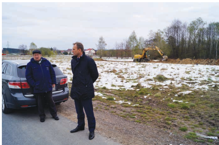
Wójt Gminy Zbigniew Piątek z wykonawcą budowy kanalizacji w Janowie omawiają szczegóły inwestycji (fot. archiwum BCK)
