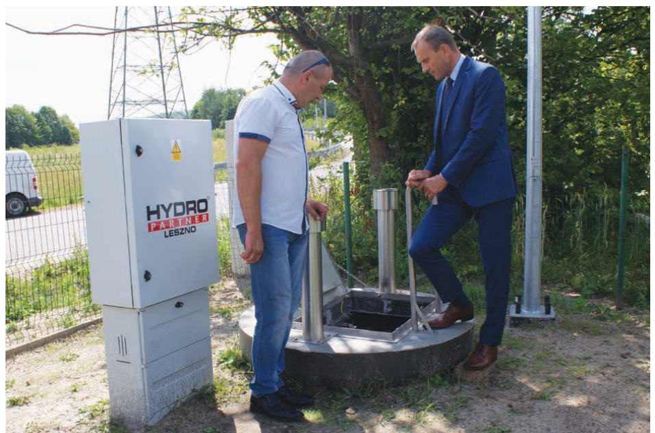
Wójt Gminy oraz Radny Dariusz Lis podczas odbioru części kanalizacji w Janowie Dolnym. (fot. BCK)
