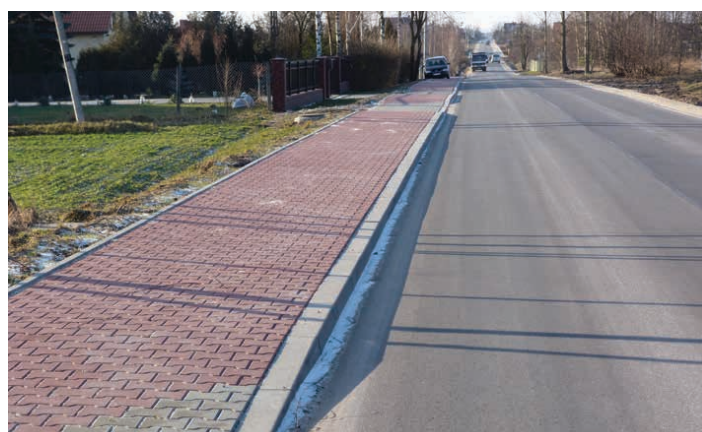
Nowa powierzchnia asfaltowa oraz chodnik w Podzamczu.
