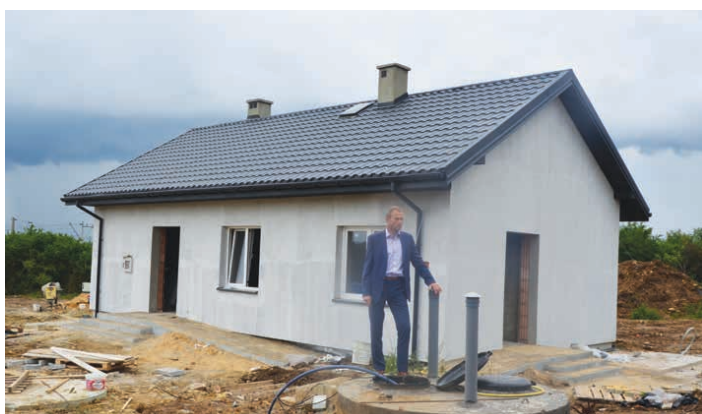
Nowe ujęcie wody w Lesicy.
