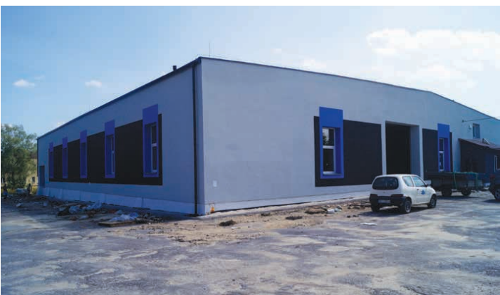
Termomodernizacja budynków gminnych m.in. ZUK-u.
