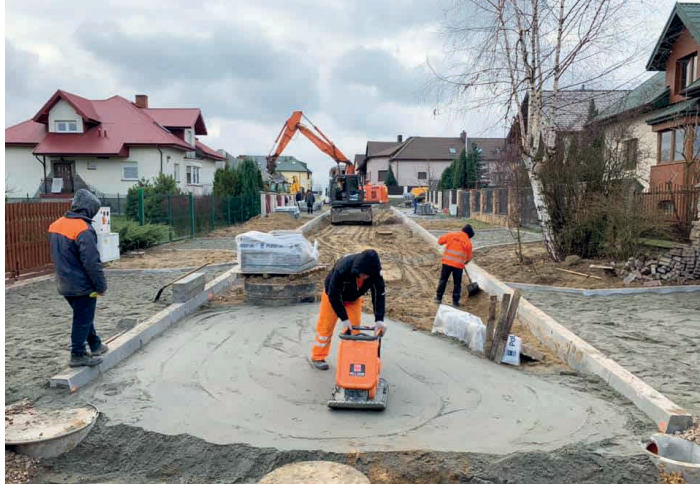
Prace na drogach dobiegają końca. (fot. CKinfo)
