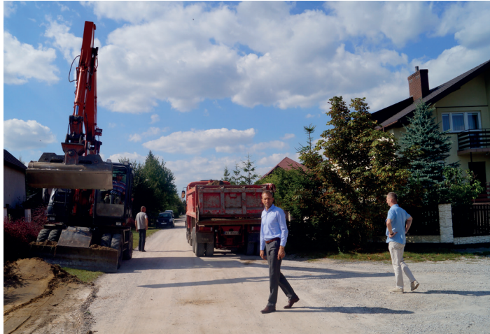
Wójt gminy nadzoruje postępujące prace na ulicach Kasztanowej i Klonowej. (fot. BCK)
