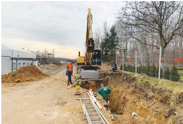
Remont ulicy Przemysłowej trwa. (fot. CKInfo)
